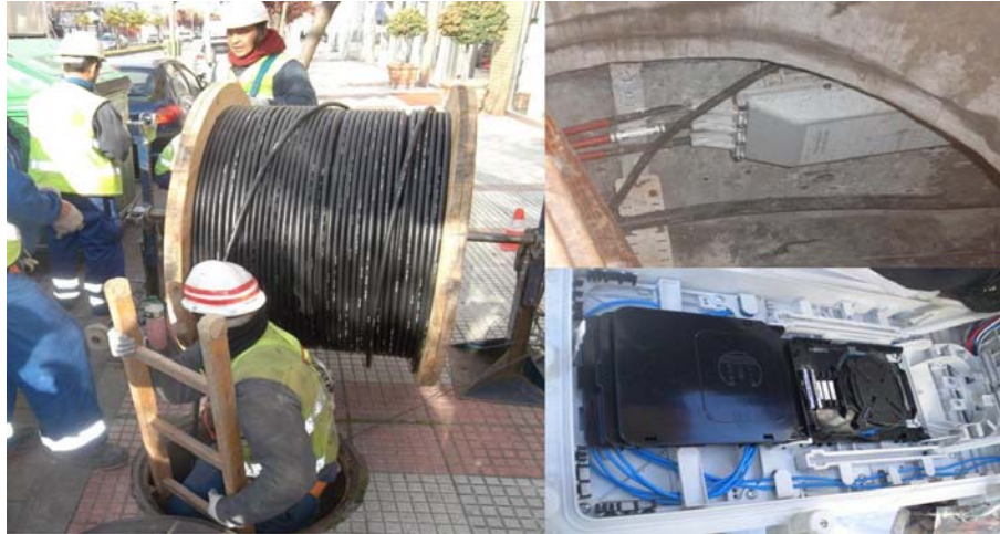
Ilustración 13. Tendido y empalme de cables en canalización.
